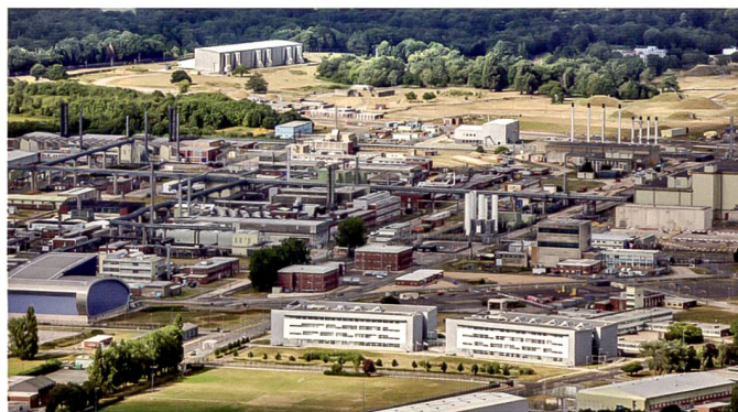
AWE Standort in Aldermaston, Südengland.
