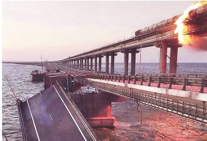
Erste Schadensbesichtigung auf der Kertsch-Brücke nach dem Anschlag. Bild: Twitter
