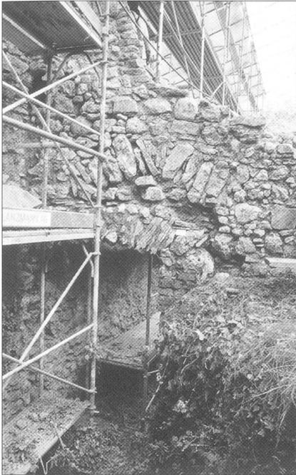
**Abb. 25** Dornach, Ruine Dorneck. Südseite der Südmauer (M18) des Nordwestbaus. Zustand während der Restaurierung 1999. Über dem aktuellen Türsturz ist der ältere zu erkennen.
