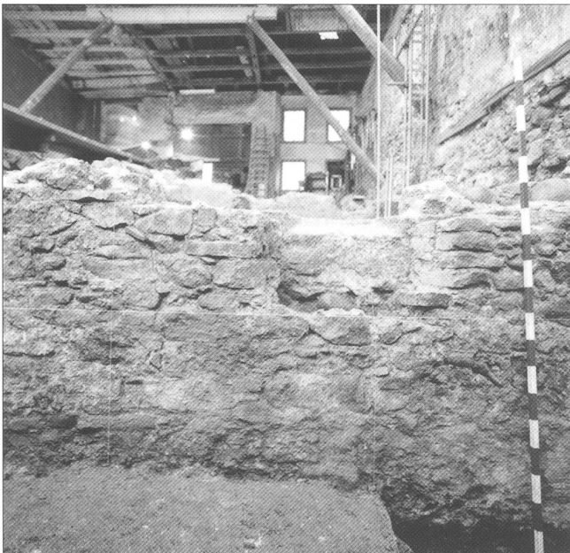
Abb. 43 Solothurn/Löwengasse 6. Mauer M131, Fenster mit tiefergelegtem Sims. Gegen Norden.
