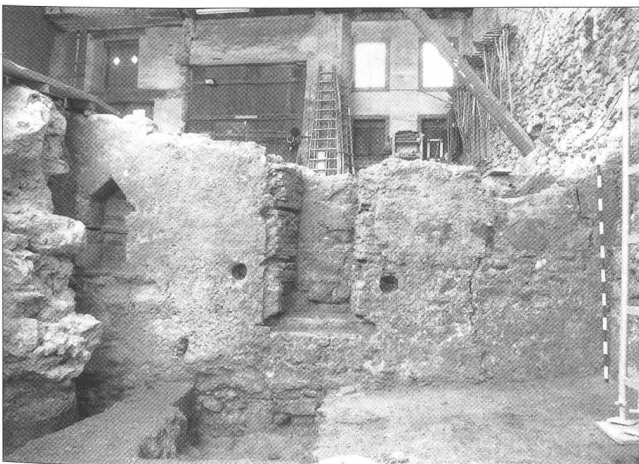
Abb. 39 Solothurn/Löwengasse 6. Kellerwand M57 mit Nischen. Gegen Norden.
