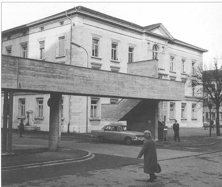
Abb. 2 Zustand 1966 nach dem Bau des Stadthauses.
