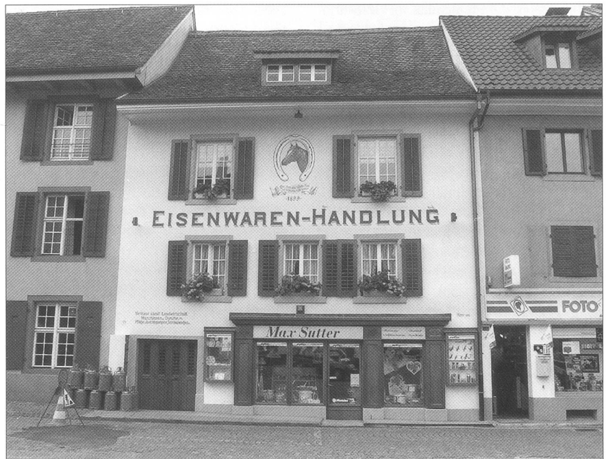
Dornachbrugg, Amthausstrasse 23, Fassade nach der Restaurierung 1998.
