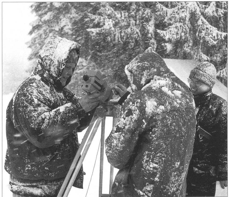
Abb. 1 Vermessungsarbeiten im Schneesturm bei den Sondierungen auf der Neubaustrecke Mattstetten–Rothrist, Bahn 2000.
