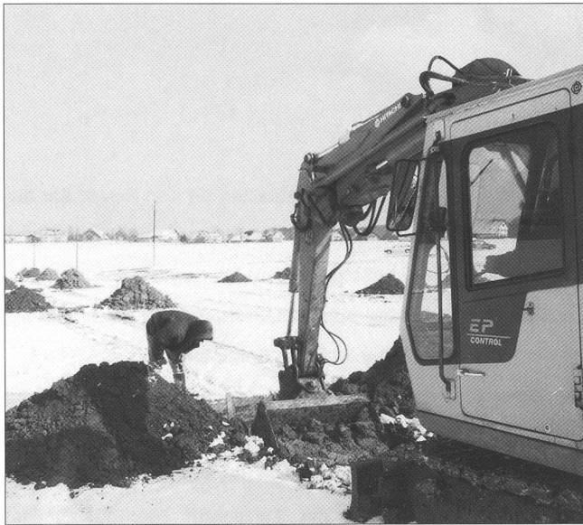
Abb. 2 Baggersondierungen bei Aeschi auf der Neubaustrecke Mattstetten–Rothrist, Bahn 2000.
