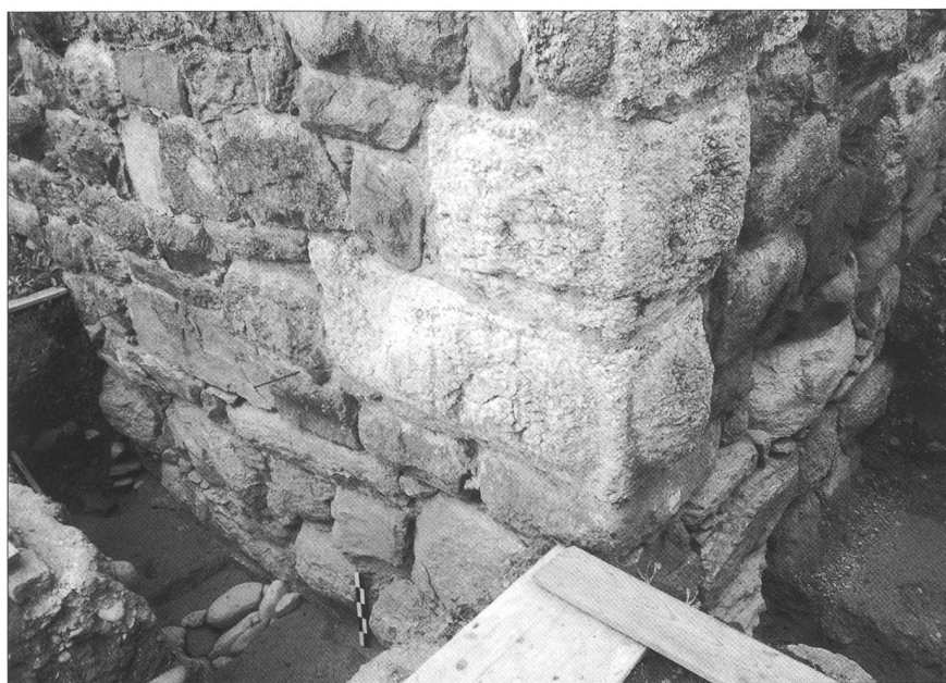
Abb. 16 Halten/Turm zu Halten. Ostecke des Turmes.
