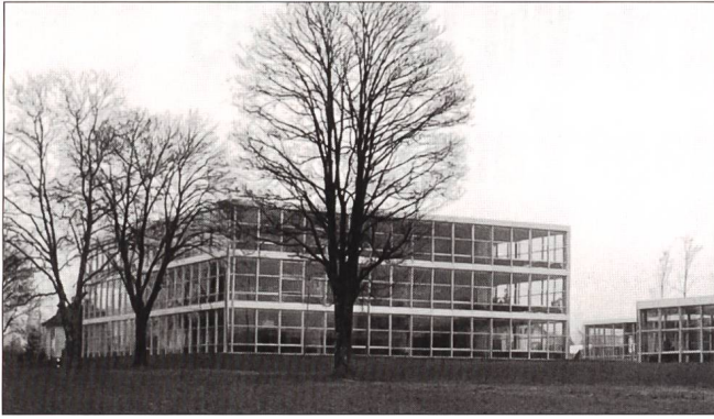
Abb. 2 Hans Zaugg, Abschlussklassenschulhaus (1962–68), Frauenfeld.
