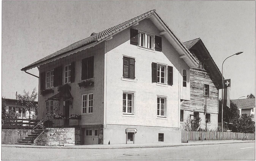
Abb. 1 Horriwil, Haus Hauptstrasse 25 nach der Fassadensanierung 2005.
