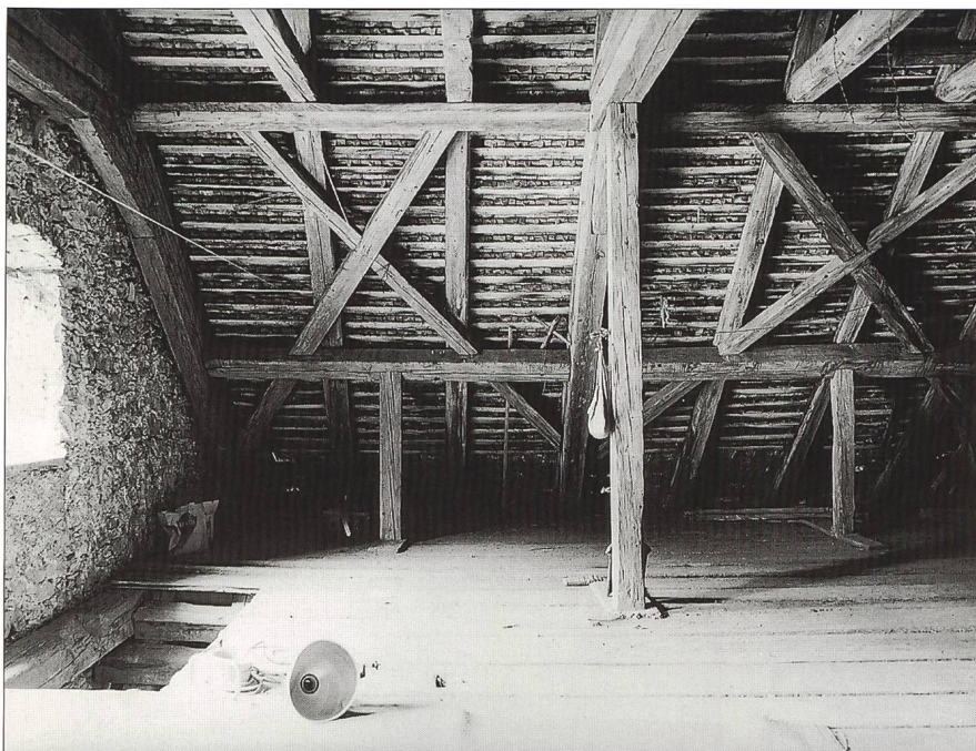
Abb. 12 Die weitgehend intakt erhaltene Dachkonstruktion mit sogenannten «Andreaskreuzen», die als Windverstrebung dienen. Der liegende Dachstuhl ist laut Arbeitsvertrag 1594/95 von Wer(n)li Meyer aus Erschwil verfertigt worden. Zustand 1999.
