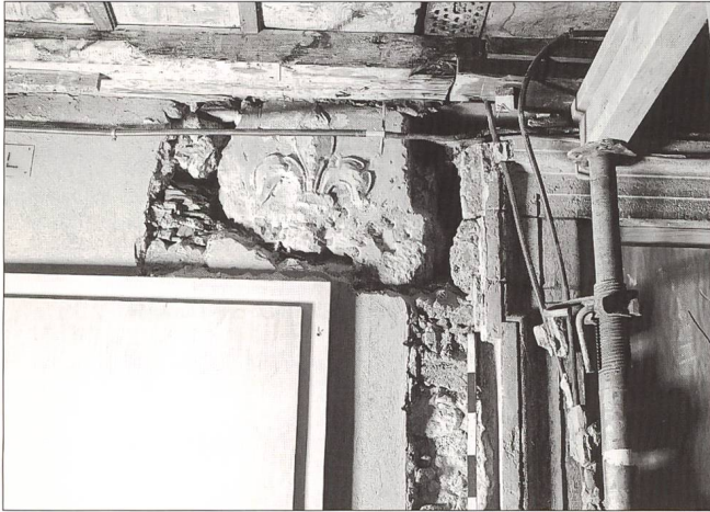
Abb. 5 Befund über der ehemaligen Tür zum Treppenturm. Der lilienförmige Dekor ist in ein Werkstück aus Hauteriveststein gehauen, er ist wahrscheinlich Teil einer früheren Türrahmung aus der Bauzeit von 1580. Rechts die um die Mitte des 17. Jahrhunderts neu erstellte Tür zum Treppenturm.
