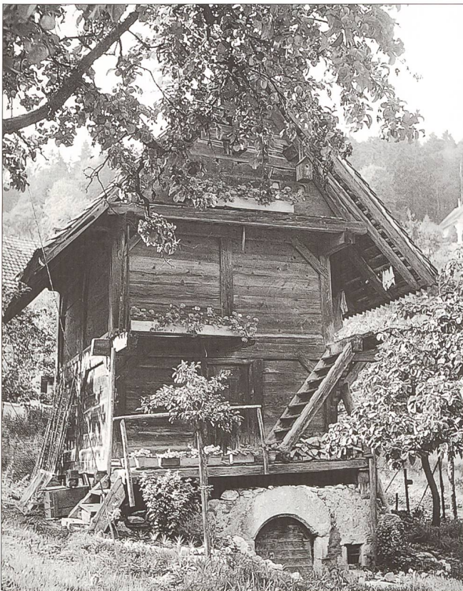
Abb. 1 Südwestansicht Zustand Juli 1948.
