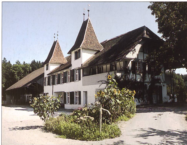
Abb. 3 Der «Buechhof» nach der Fassaden- und Dachrenovation von 2003/2004. Nordwestansicht.
