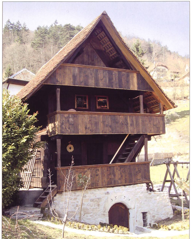
Abb. 3 Südwestansicht nach der Instandstellung von 2004.
