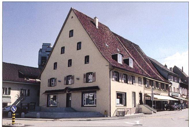
Abb. 2 ...und nach der Restaurierung 2005.
