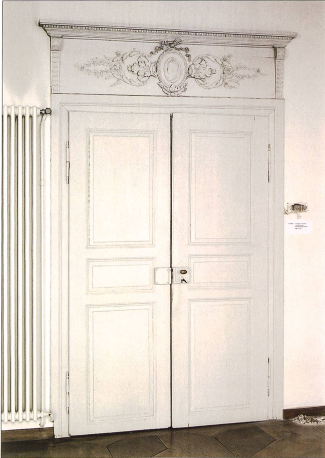
Abb. 4 Eine der Doppelflügeltüren ist eine Blindtür...
