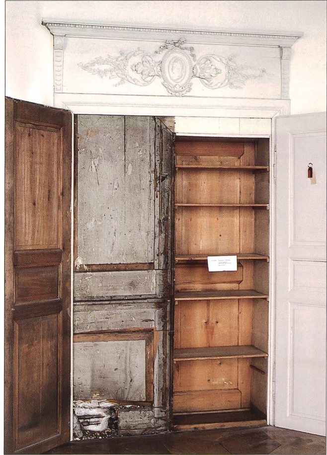
Abb. 5 ...hinter deren Hälfte hatte sich ein Fragment des bauzeitlichen Wandtäfers erhalten.
