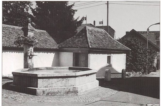
Abb. 2 ... und nach der Restaurierung 2005.
