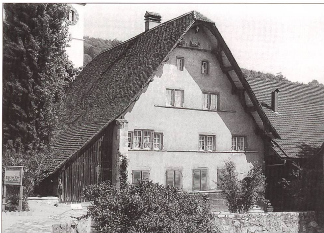
Abb. 4 Ein halbes Jahrhundert lang war die Erscheinung des Hauses durch die Renovation von 1953 geprägt. Ein naturfarbiger Abrieb und steinhauerisch überarbeitete Gewände hatten zu einem «materialgerechten» Resultat geführt.
