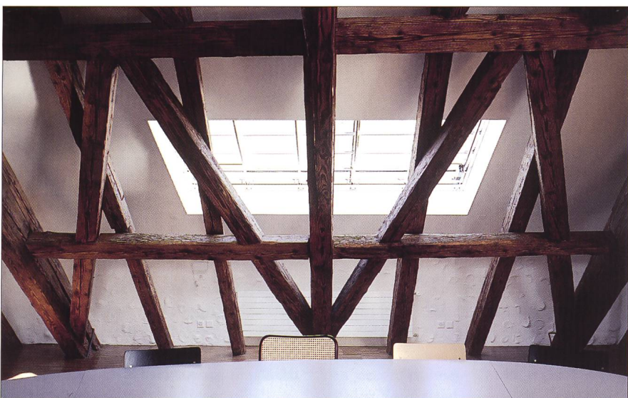
Abb. 4 Die intakt erhalten gebliebenen Windverstrebrungen in der nördlichen Dachfläche mit dem neuen Fenster in der Dachfläche.
