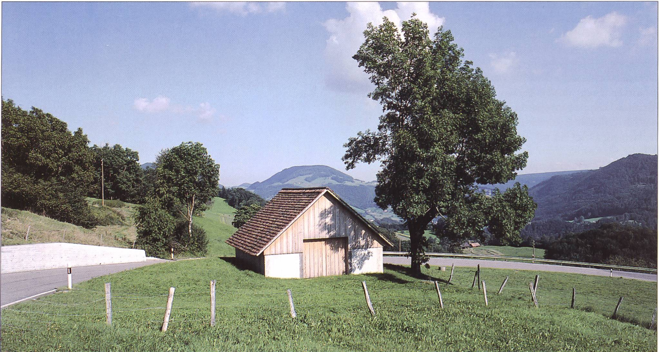
Abb. 1 Ramiswil, Weidscheune Hagli nach der Sanierung 2005.
