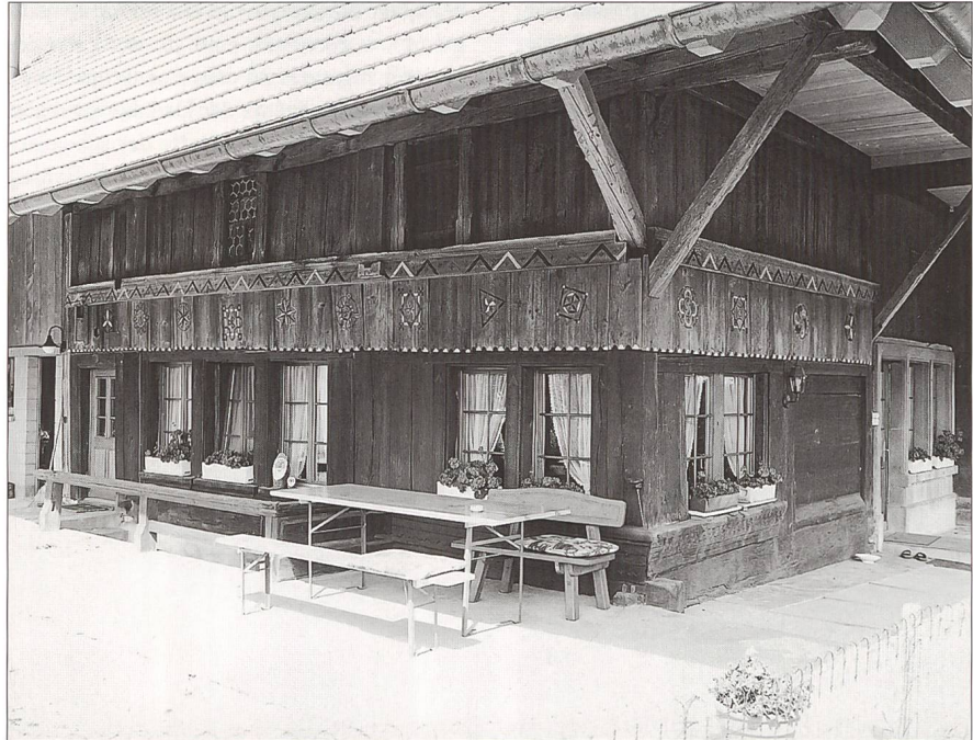
Abb. 1 Messen, Bauernhaus Pfarrweg 5, Dachsanierung und Restaurierung der Malereien 2005.
