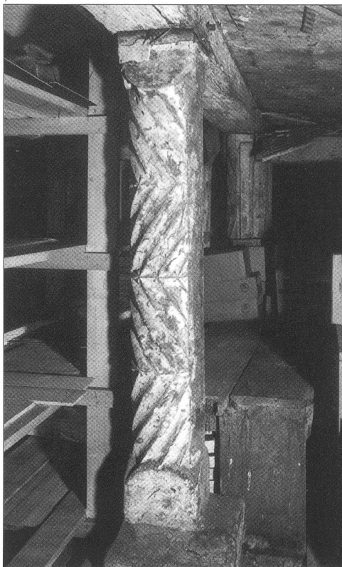
Abb. 1 Solothurn, Hauptgasse 36, Fenstersäule aus dem 16. Jh., heute als Stütze im Keller verwendet.
