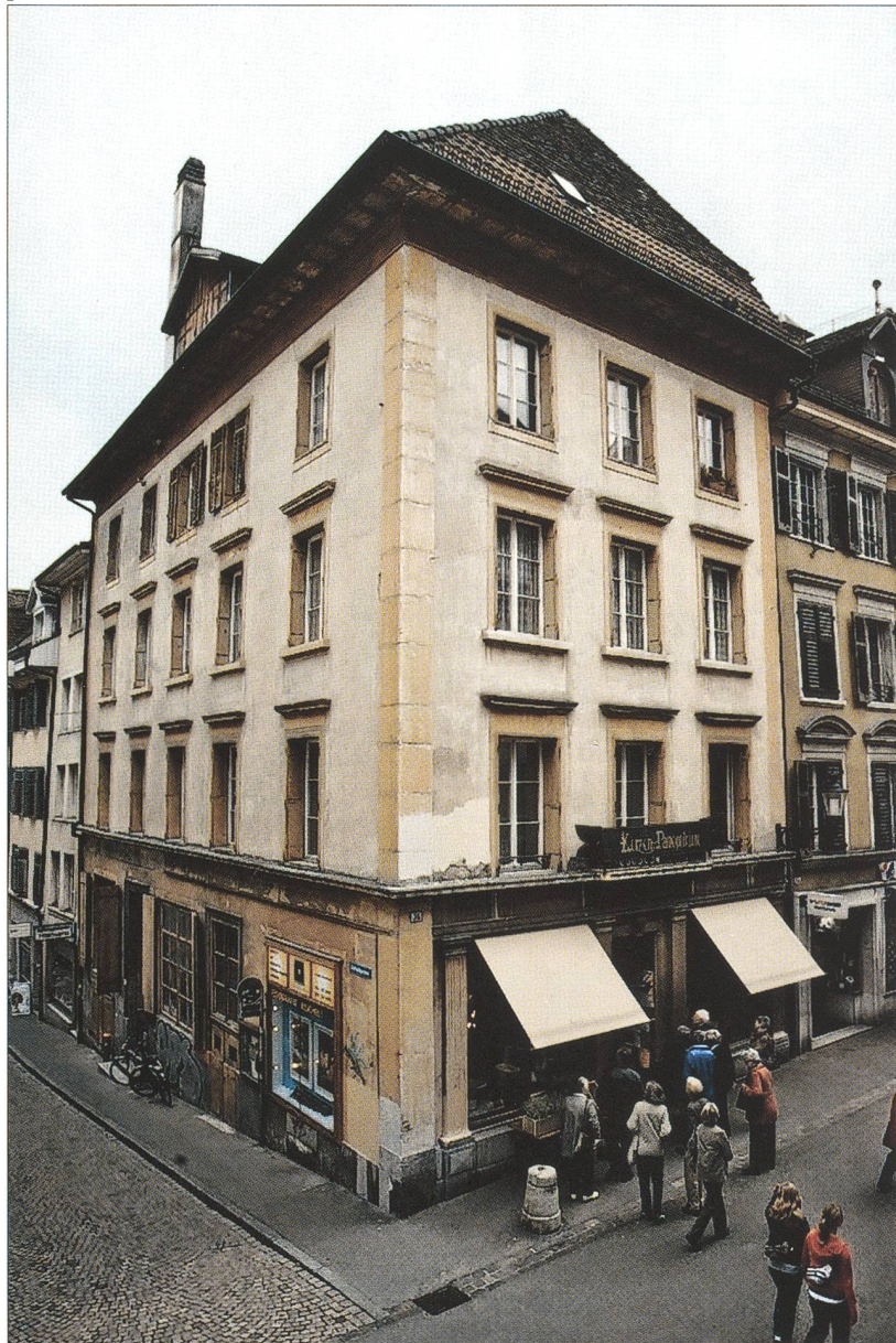
Abb. 2 Zustand vor der Restaurierung 2008.
