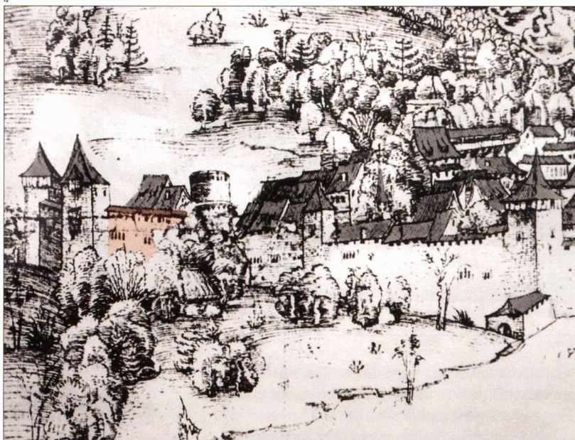
Abb. 4 Ausschnitt aus der ältesten Stadtansicht von Solothurn von Urs Graf, um 1508/1510. Abschnitt der mittelalterlichen Stadtmauer zwischen dem Bieltor und dem südlichen Schalenturm, dahinterliegend die Schmiedengasse. Regelmässiger Zinnenkranz mit ziegelgedecktem Wehgang. In der Mitte ist ein kleiner Wehrmauererker sichtbar.
