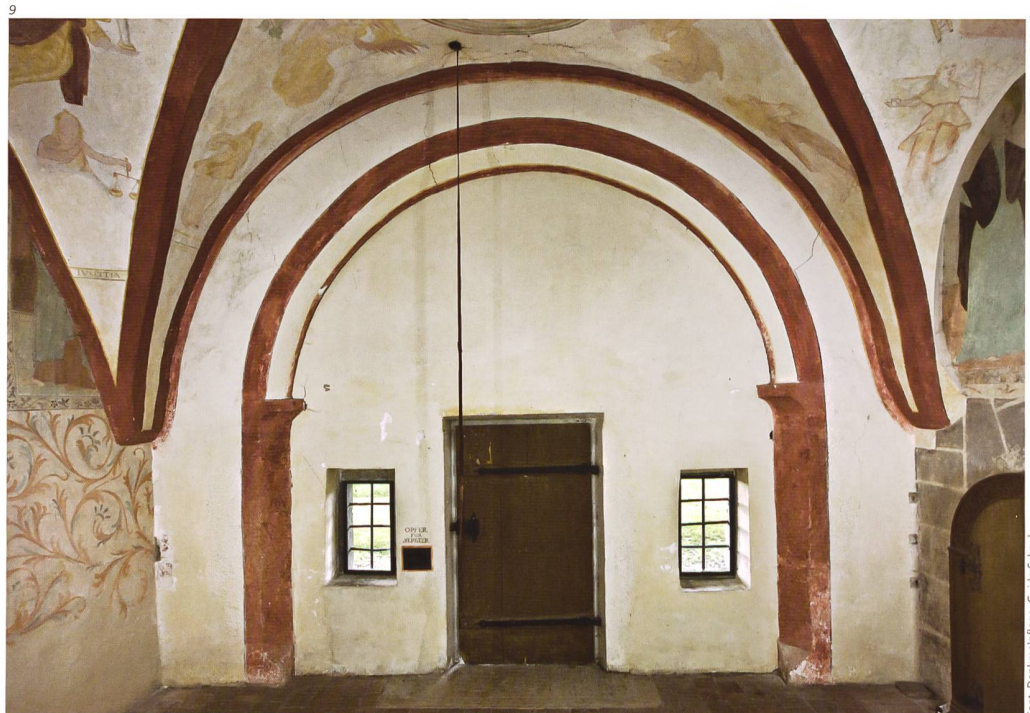
Kant. Denkmalpflege, Guido Schenker
