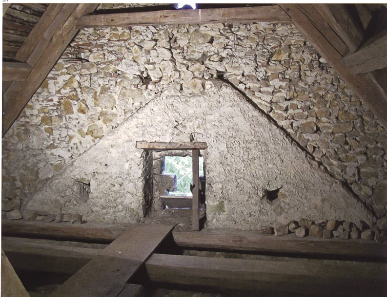
Abb. 31 Dachstock, Blick zur Ostmauer. Gut erkennbar ist das alte Giebelmauerwerk mit der dazugehörigen Dachneigung. Die Giebelmauer wurde in zwei weiteren Bauetappen erhöht.
