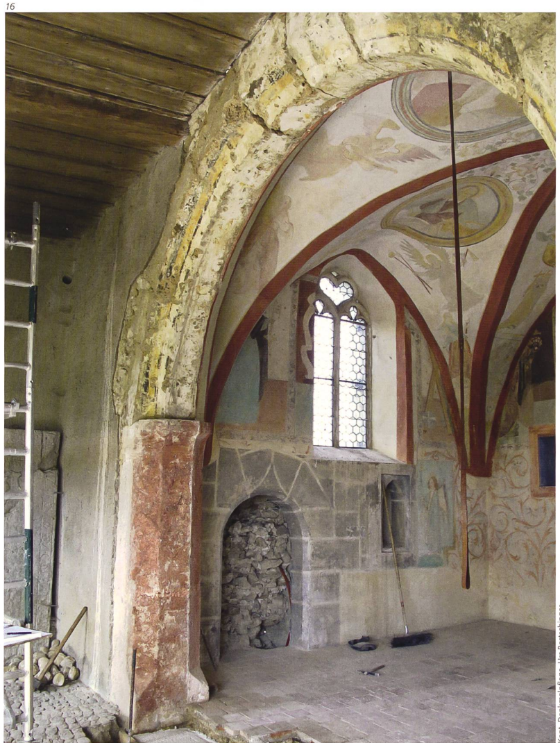
Abb. 16 Chorbogen während der Renovation. Zustand nach dem Abbruch der nachträglichen Ausmauerung. Blick gegen innen auf die Nordmauer des Chores, in der Mitte die ehemalige Sakristeitür.
