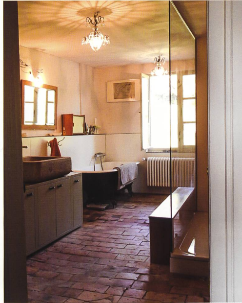
Abb. 22 Der Tonplattenboden im heutigen Bad stammt von einer früheren Umnutzung als Küche – darunter liegt noch das Felderparkett.
