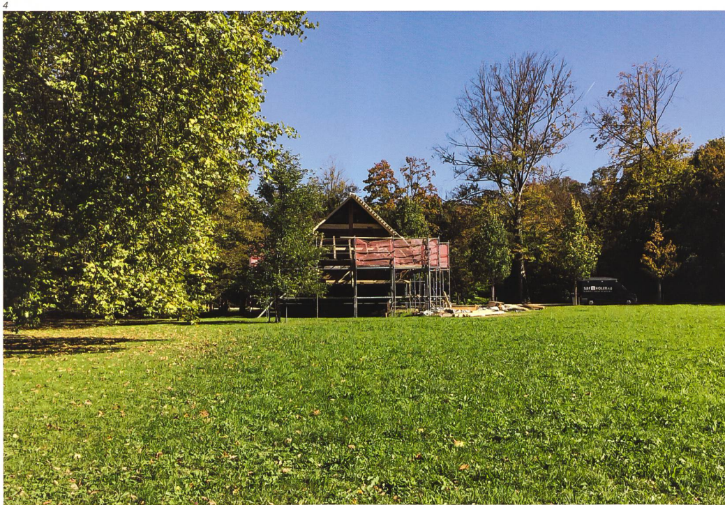
Abb. 4 Der eingerüstete Kornspeicher im Landschaftsgarten.
