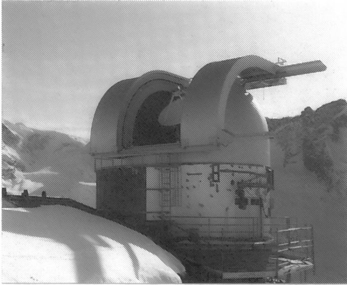
Abb. 4: Das 3 m Radioteleskop in seiner schützenden Kuppel.
