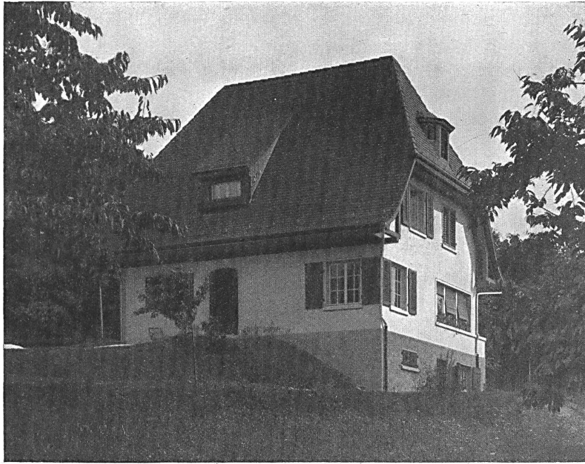
Façades nord et ouest
