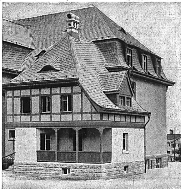
Couverture en Éternit vieux style allemand :: Les faites, :: couloirs et lucarnes entièrement couverts en Éternit ::
