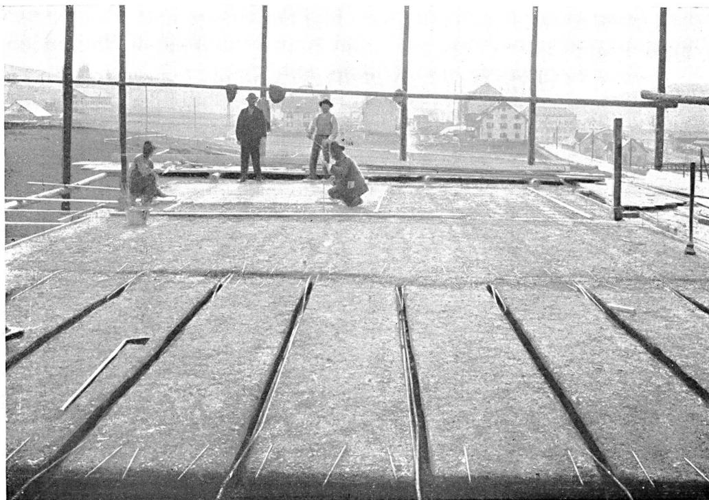
Le béton armé dans la construction d'immeubles industriels. Après le remplissage.
