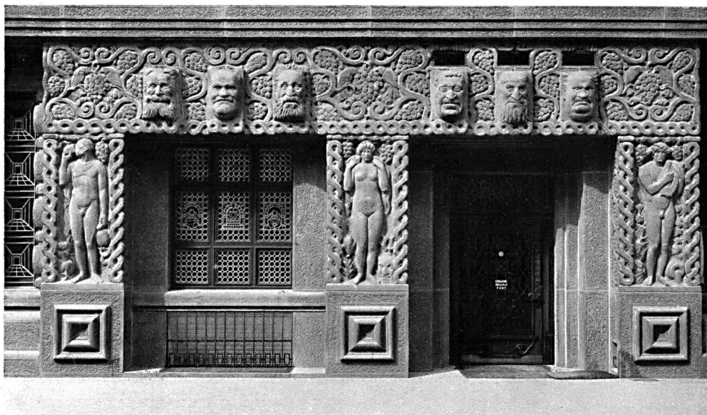
La maison « Du Pont » à Zurich. — L'entrée sur le Beatenplatz; motif en pierre artificielle noire. Architectes: Haller & Schindler, Zurich.
