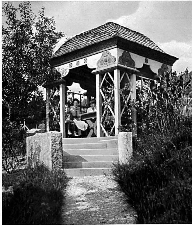
Pavillon de jardin de M. Rob. Faller à Zurich. Architecte: Otto Zollinger, Zurich.
