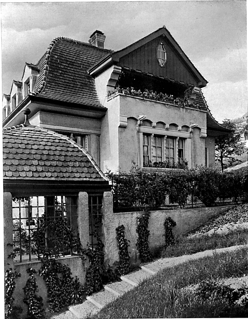
Maison de M. le Prof. Dr. A. Wreschner à Zurich. — Façade sud. Architecte : Otto Zollinger, Zurich.
