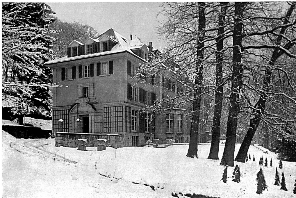
Institut de jeunes gens « La Chablière » près Lausanne. — Vue prise du chemin d'accès. Architecte: Georges Epiteaux, Lausanne.
