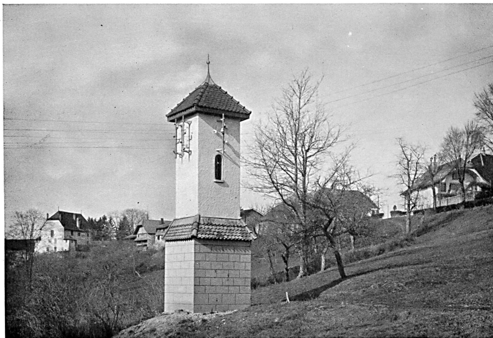
Tourelle de transformateur. Architectes : Waeber & Gribi, Bulle.
