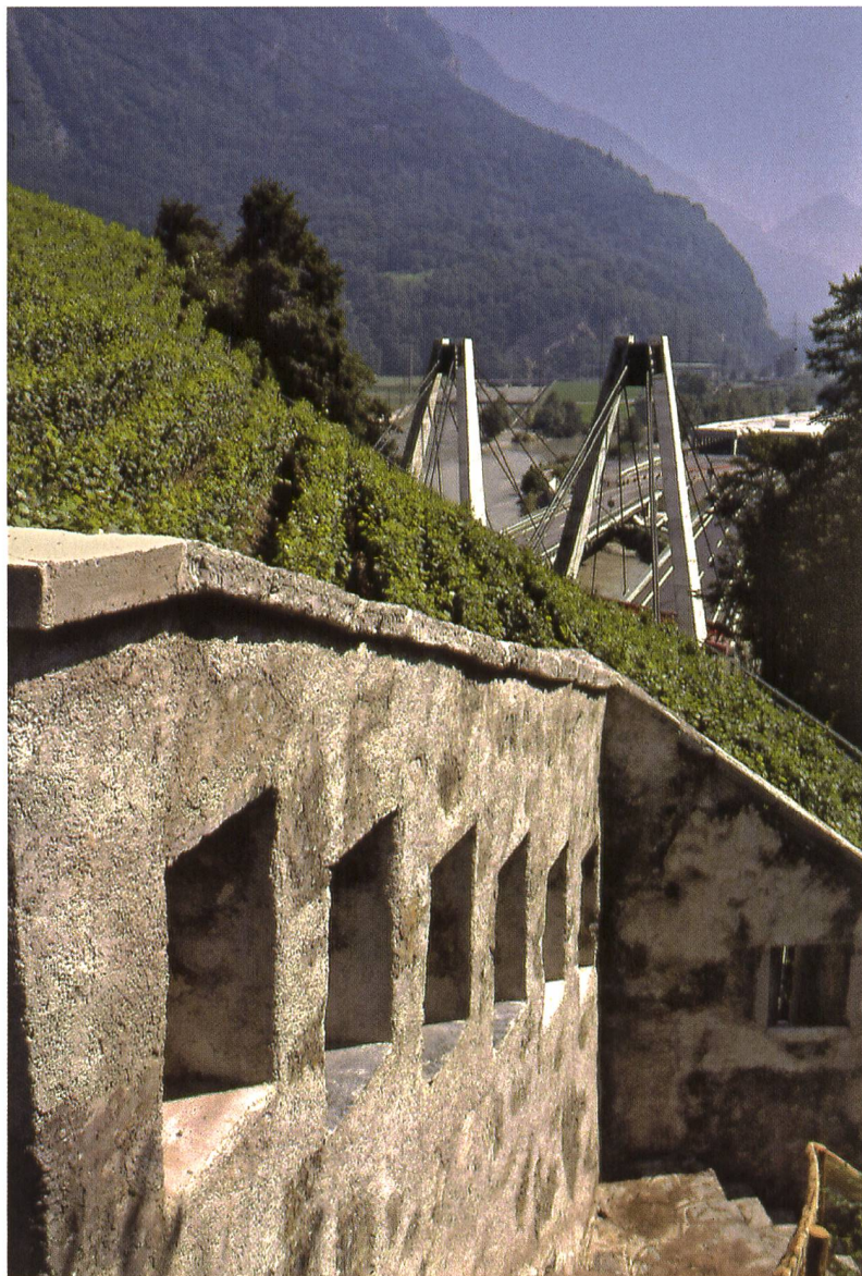
Fig. 20 N9a. Fortifications Dufour. Mur crénelé de Lavey, avec en arrière-plan le viaduc de l'autoroute qui traverse le Rhône (© Archéologie cantonale, Lausanne).
