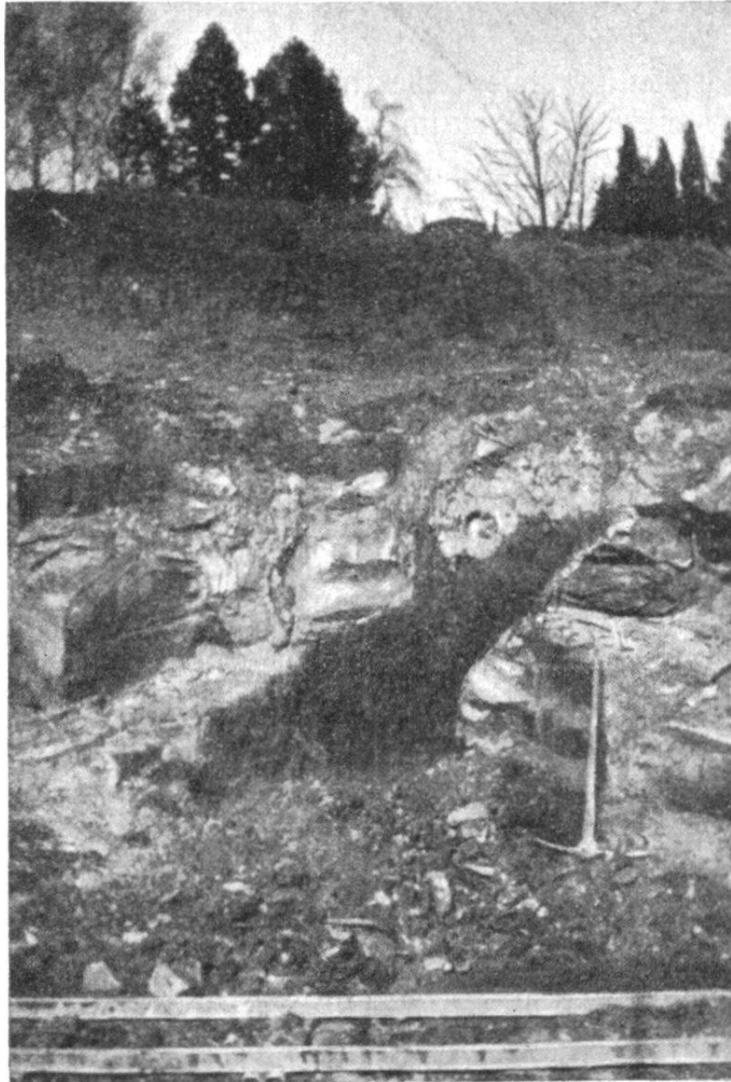
Baustelle des Hauptgebäudes. Standpunkt: Terrasse 403,6. Volustasche in den Kalksteinschichten. Darüber Moräne.
