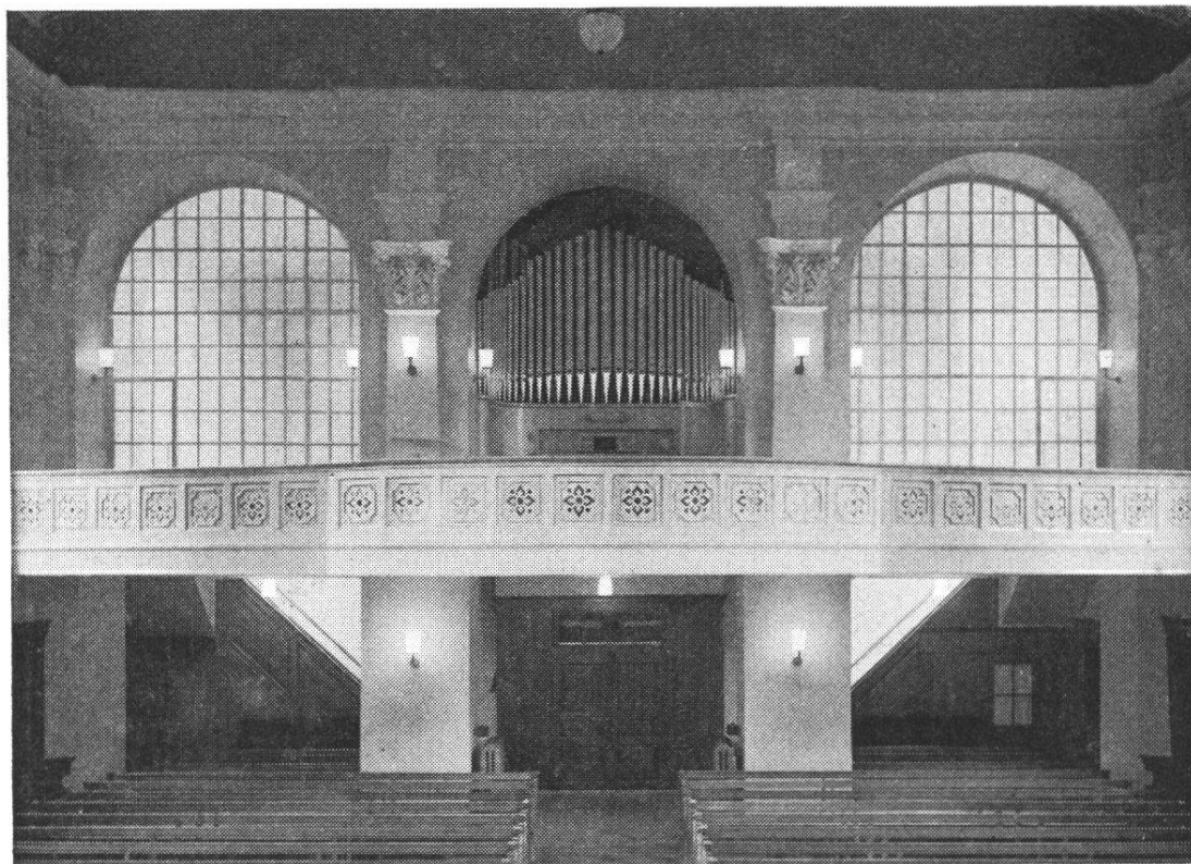
Ansicht der umgebauten Empore und Orgel
