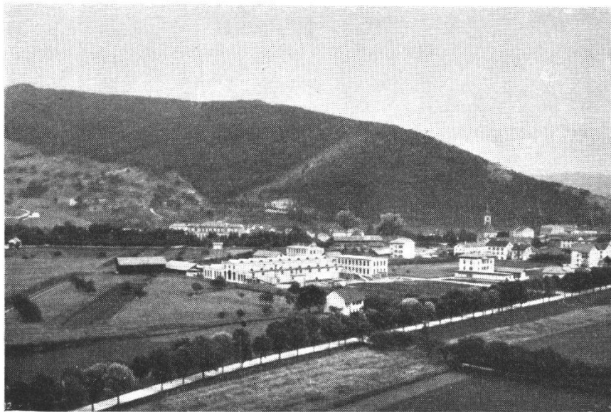
Die Fabrikanlage im Frühjahr 1894
