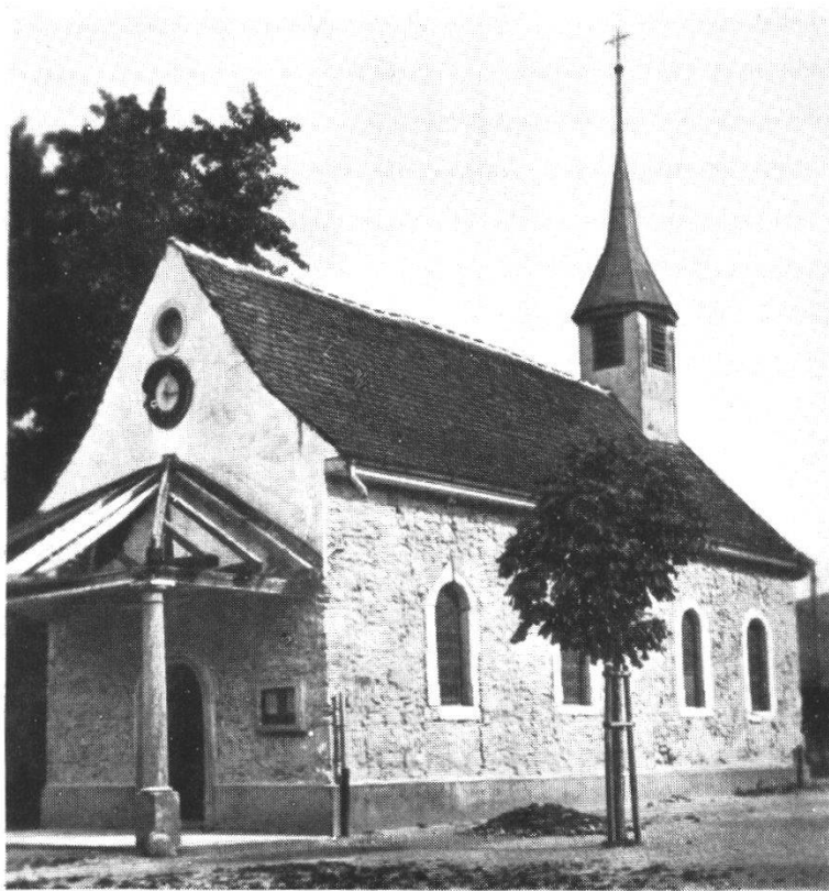
Die alte Kapelle von Freienwil beim Abbruch 1923
