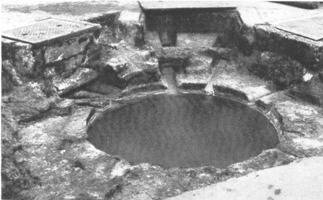
Abb. 9 Quellfassung unter dem Grossen Heissen Stein mit dem alten Verteiler aus Granit, der (v. l. n. r.) folgende Rinnen zeigt: Grand Hotel, Schweizerhof, Stadtanteil, Zufluss der Ki. Quelle, Blume.
