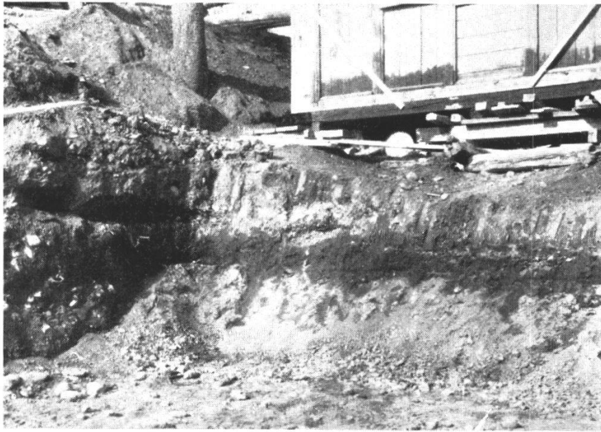
Abb. 7 Baden-Römerstrasse. Ansicht der Geländestufe „Profil D-E“ (vgl. Abbildung 3). Photo: BBC
