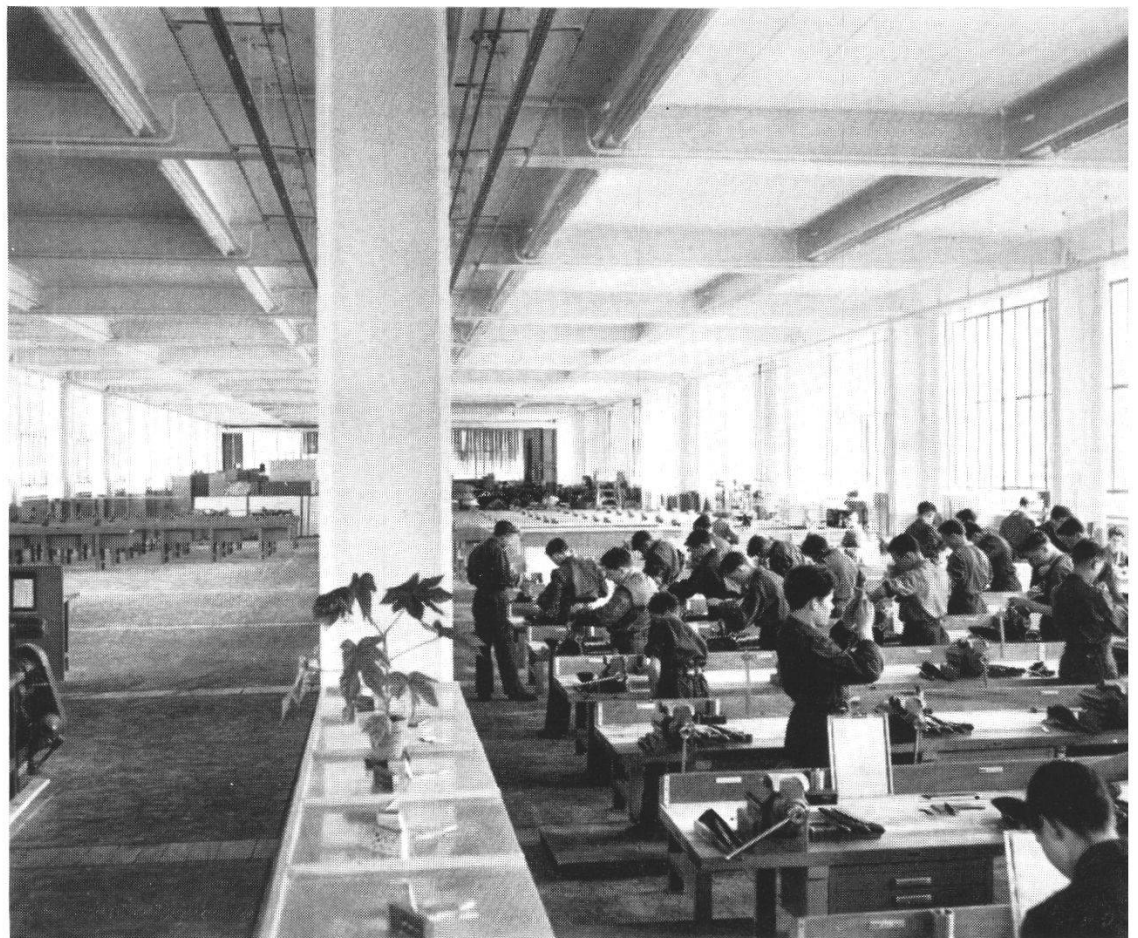
Die Lehrwerkstätte im 2. Stock des Hochbaus
