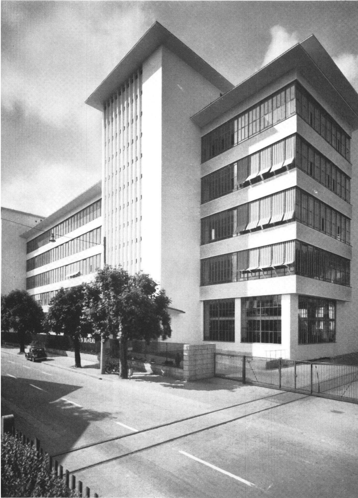
Der Hochbau an der Bruggerstraße
