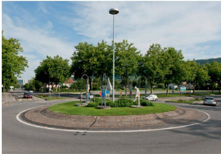
Wettingen, Zentralstrasse/ Halbartenstrasse oder Jurastrasse (Duschkreisel).
