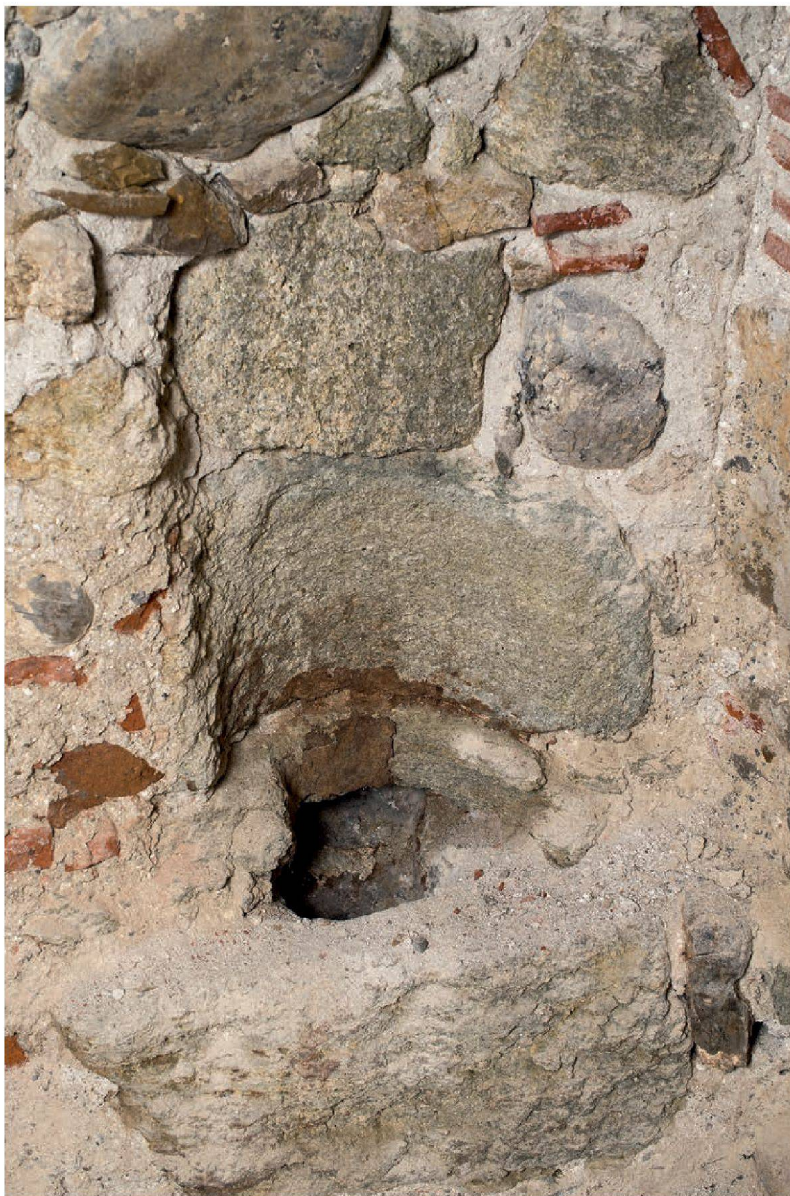
Latrine im Untergeschoss des Landvogteischlosses. Foto Alex Spichale, Baden.
