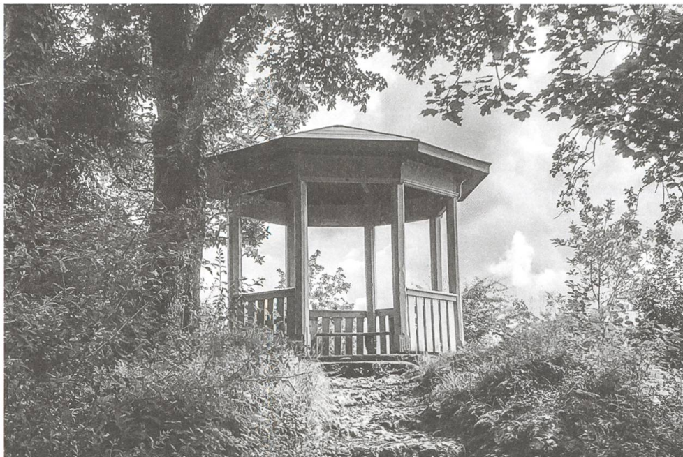
Das Känzeli auf dem Martinsberg im Zustand von 2020.
