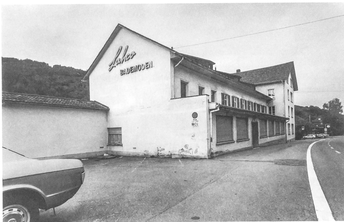
... und kurz vor dem Abbruch im Januar 1986.
