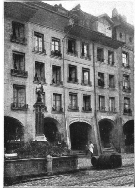
Kramgasse 39. Absteigequartier 1745—1754. (Abb. 5.)
