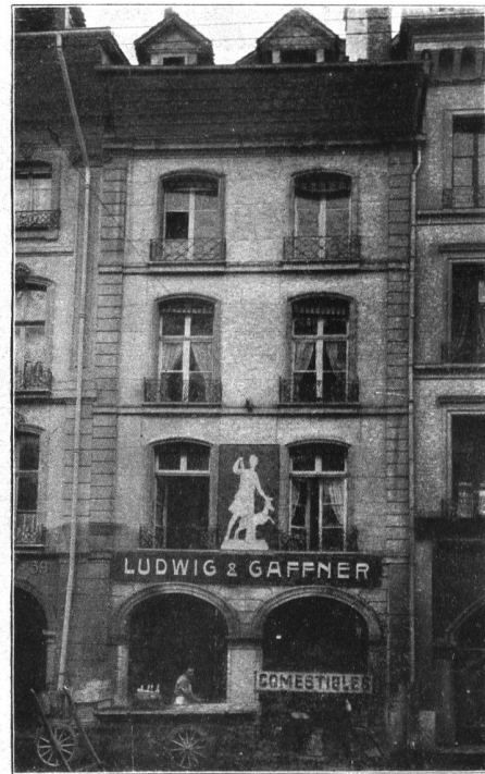
Marktgasse 61. Absteigequartier 1759—1763. (Abb. 15.)
