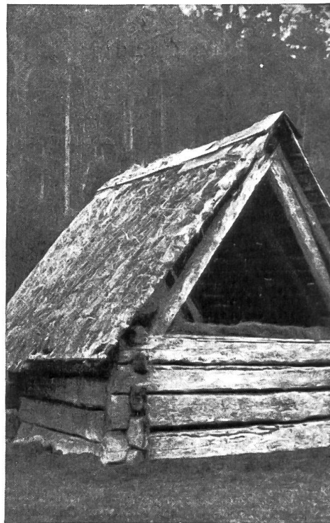
Blockbau: Gewettetes Heuhäuschen in der Kesselstatt südl. Zeglingen. Aufnahme P. Suter, 1923: Letztes Strohdach in Baselland, heute Ziegeldach.
