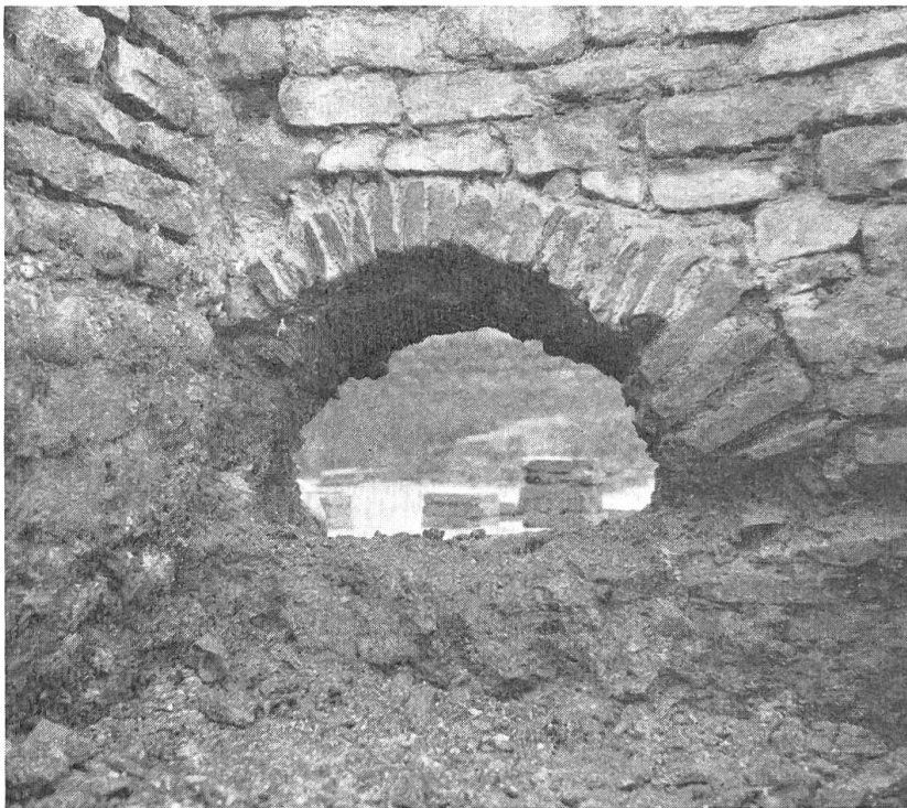
Bild 27. Aus der Südwestecke des Heizraumes U sieht man durch das ausgeflickte Gewölbe der Heizöffnung in den Hypokaust des Wohnraumes S, in dem einzelne Stützpfeilerchen noch teilweise erhalten sind. Unter dem Gewölbe liegt eine 20 cm hohe Aschenschicht. Links die Mauer gegen das Schwitzbad T, dessen Heizung ebenfalls durch ein Ziegelgewölbe aus demselben Heizraum bedient wurde.
