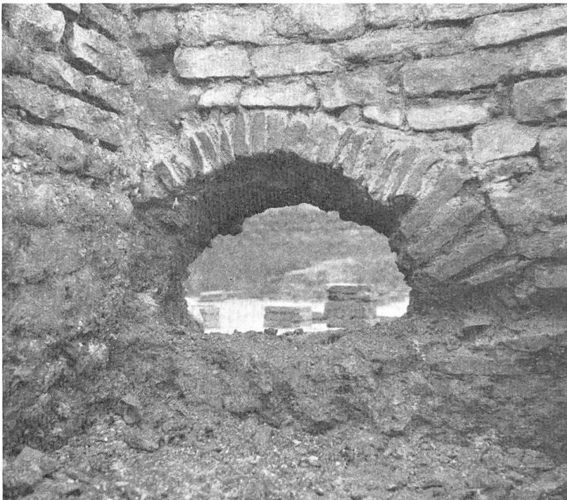
*Bild 27.* Aus der Südwestecke des Heizraumes U sieht man durch das ausgeflickte Gewölbe der Heizöffnung in den Hypokaust des Wohnraumes S, in dem einzelne Stützpfeilerchen noch teilweise erhalten sind. Unter dem Gewölbe liegt eine 20 cm hohe Aschenschicht. Links die Mauer gegen das Schwitzbad T, dessen Heizung ebenfalls durch ein Ziegelgewölbe aus demselben Heizraum bedient wurde.
