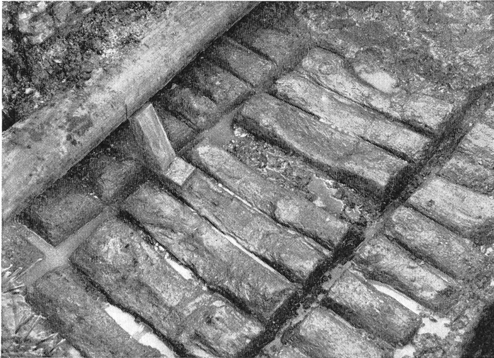
Bild 9. Der im Jahre 1957 aufgedeckte Bohlenweg an der alten Strasse beim Kurhaus Langenbruck. Spurweite der Karregeleise innerkant 105,4 cm. Photo Th. Strübin.
