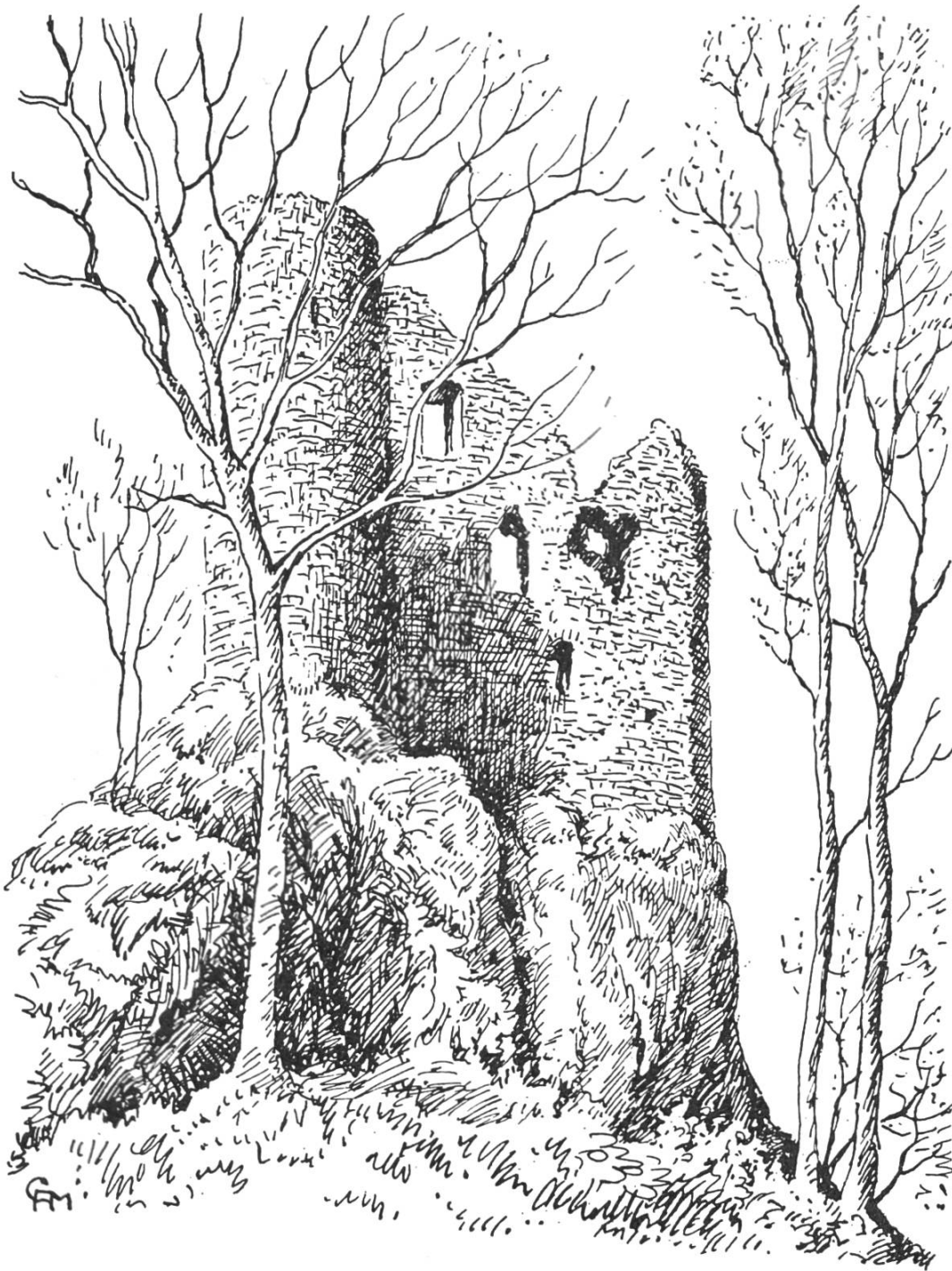
Bild 3. Burg Reichenstein vor dem Wiederaufbau. Nach einer Federzeichnung von C. A. Müller.
