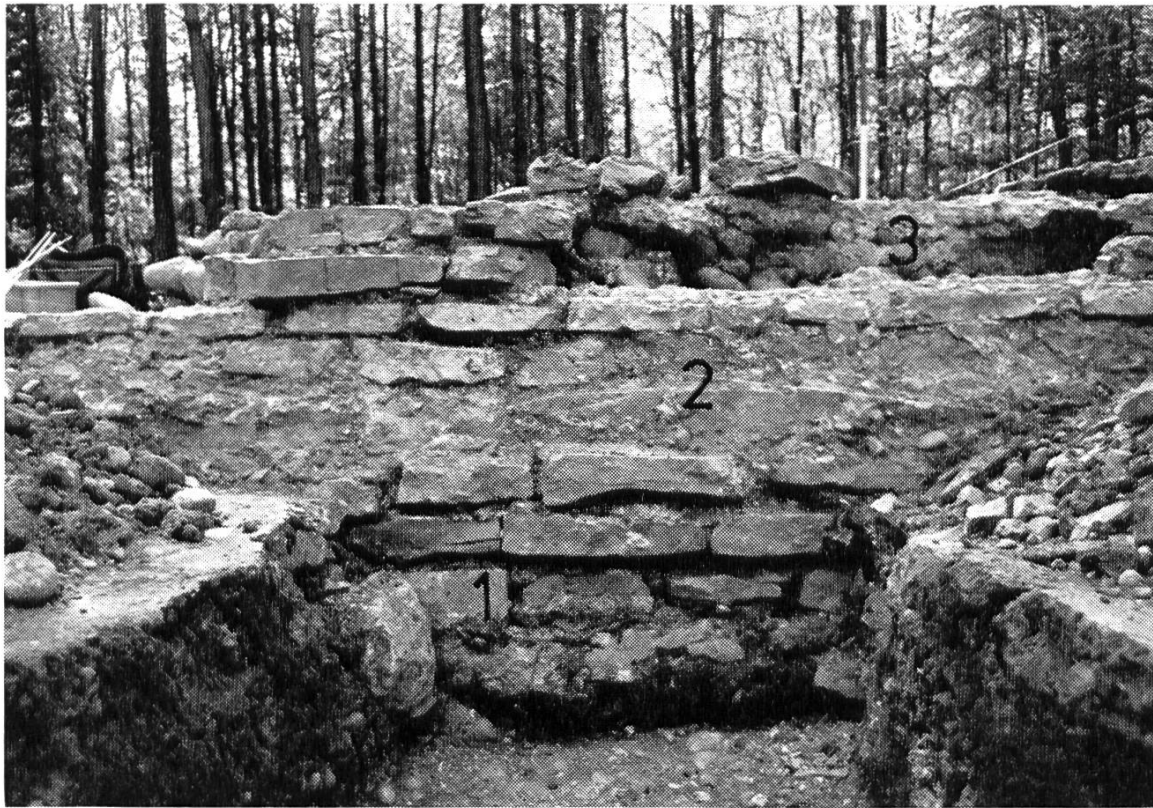
Bild 10. Aussenansicht der Nordmauer. 1 = Fundament. 2 = Aufgehendes. 3 = Balkenlager bzw. Kiesel/Mörtel-Guss.
