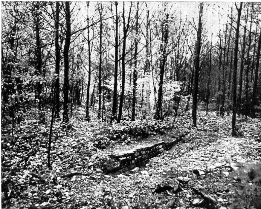
Bild 1. Um den «Turm» im Herbst 1974 überhaupt fotografieren zu können, bedurfte es mehrstündiger Such- und Schürfarbeiten, bis ein kläglicher Mauerrest unter den Schuttwällen zum Vorschein kam.
