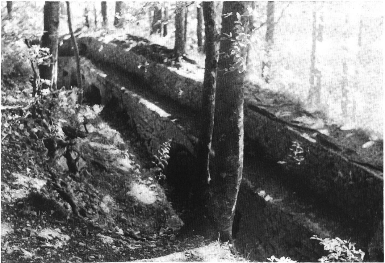
Bild 5. Laufgraben am Spitzenflüeli.
