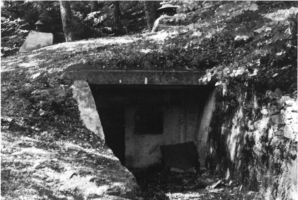
Bild 4. Betonierter Unterstand am Ruchen als «Zweitwohnung».
