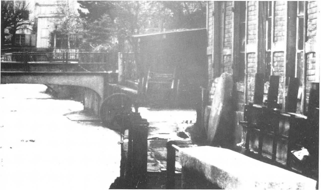
Die «Schlifi» mit Kanaleinlauf (um 1930).
