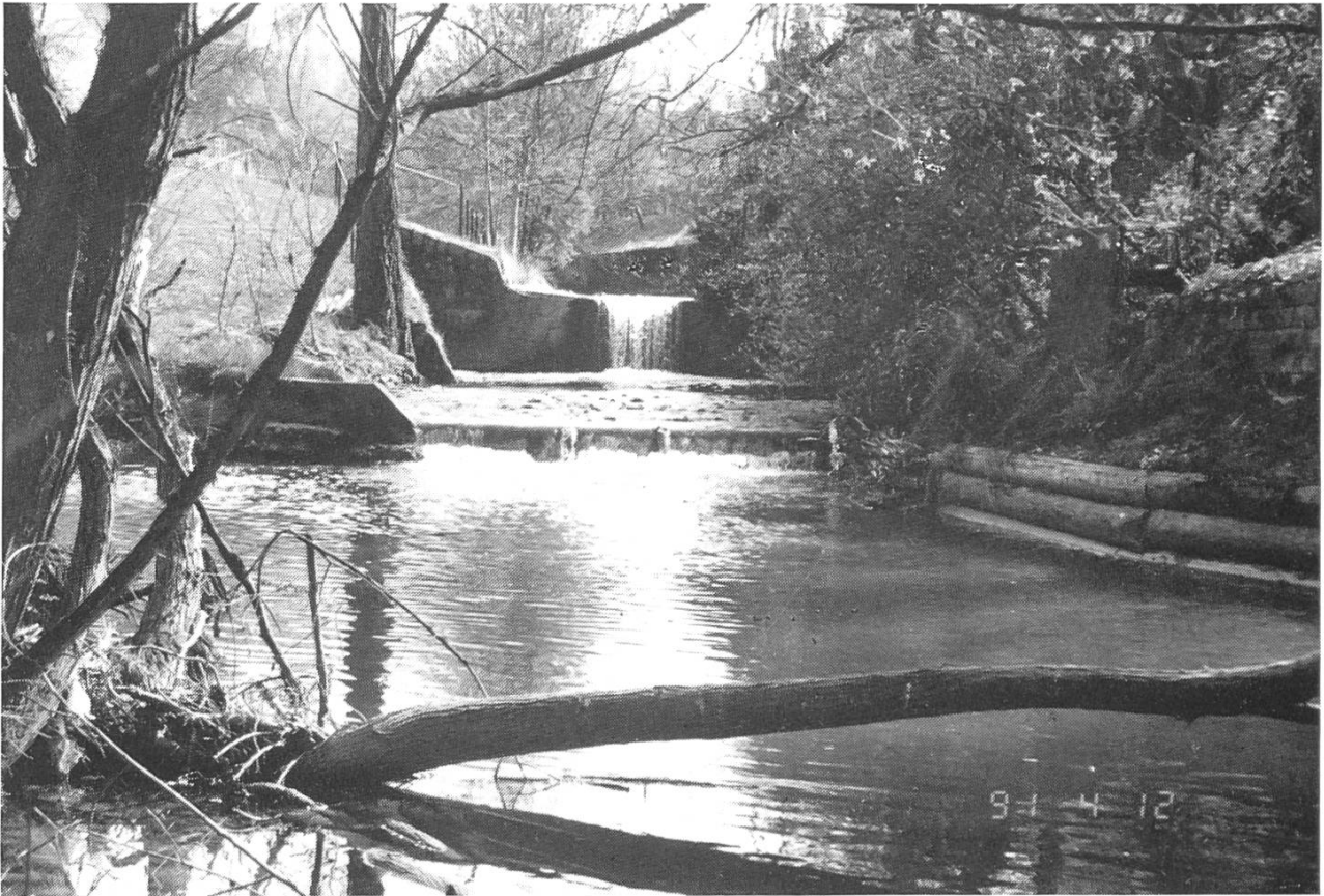
Unterer Absturz und Mündung des Zunzgerbaches in die Ergolz.
