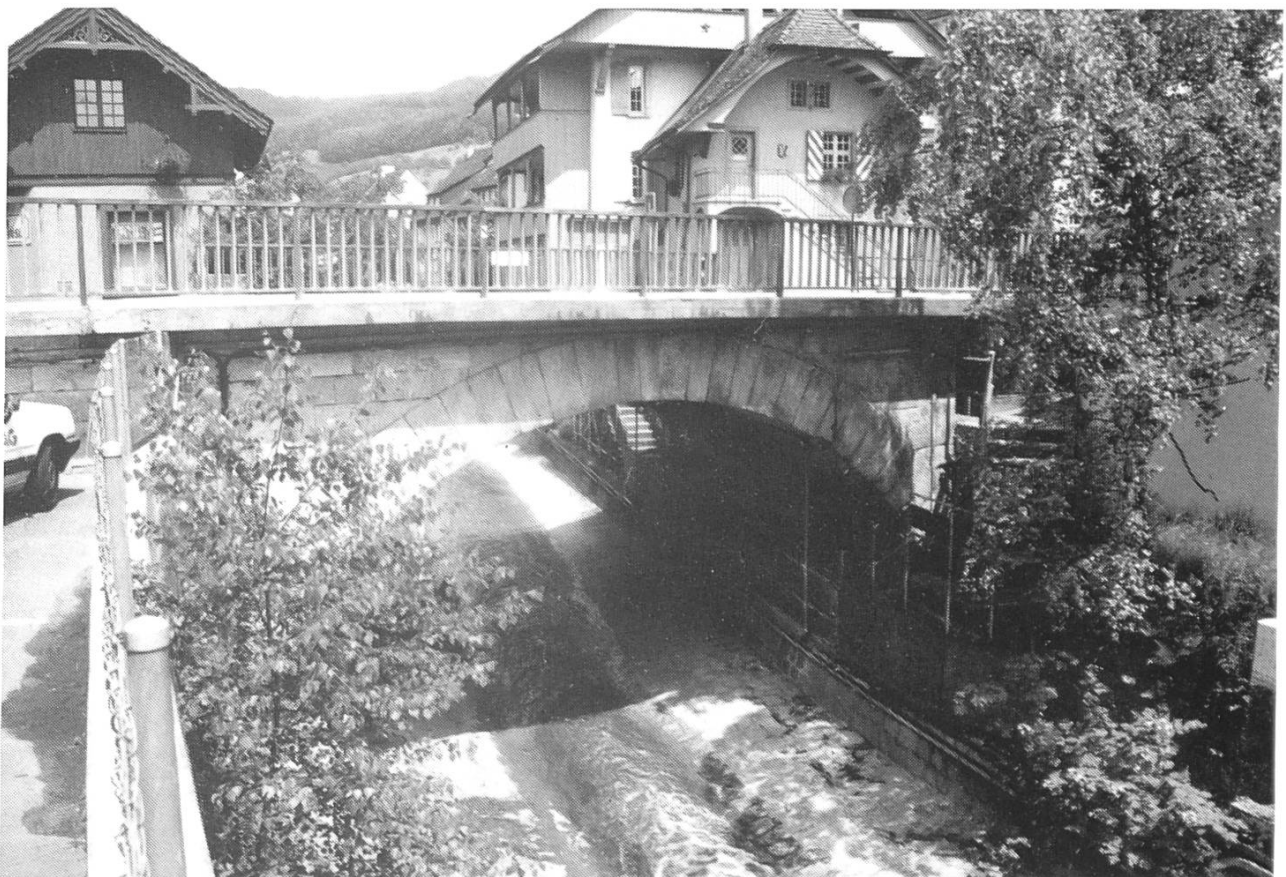
Die Brücke über die Hauptstrasse; erbaut 1850.
