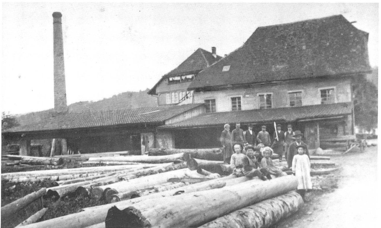
Die Sägerei in einer Ansicht von 1905.
