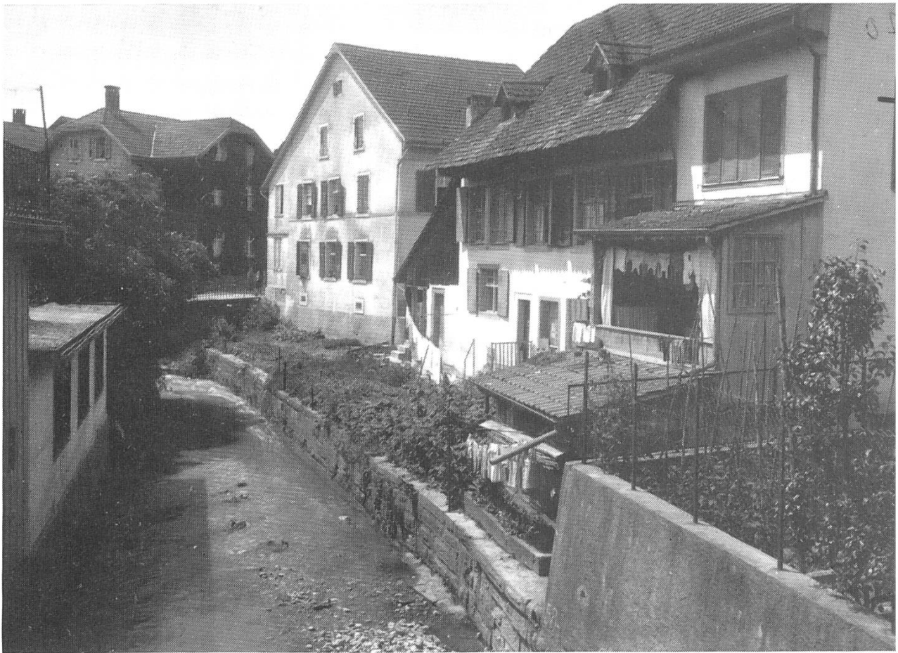
Blick von der Brücke über die Hauptstrasse bachaufwärts; Ufermauer aus Naturstein.
