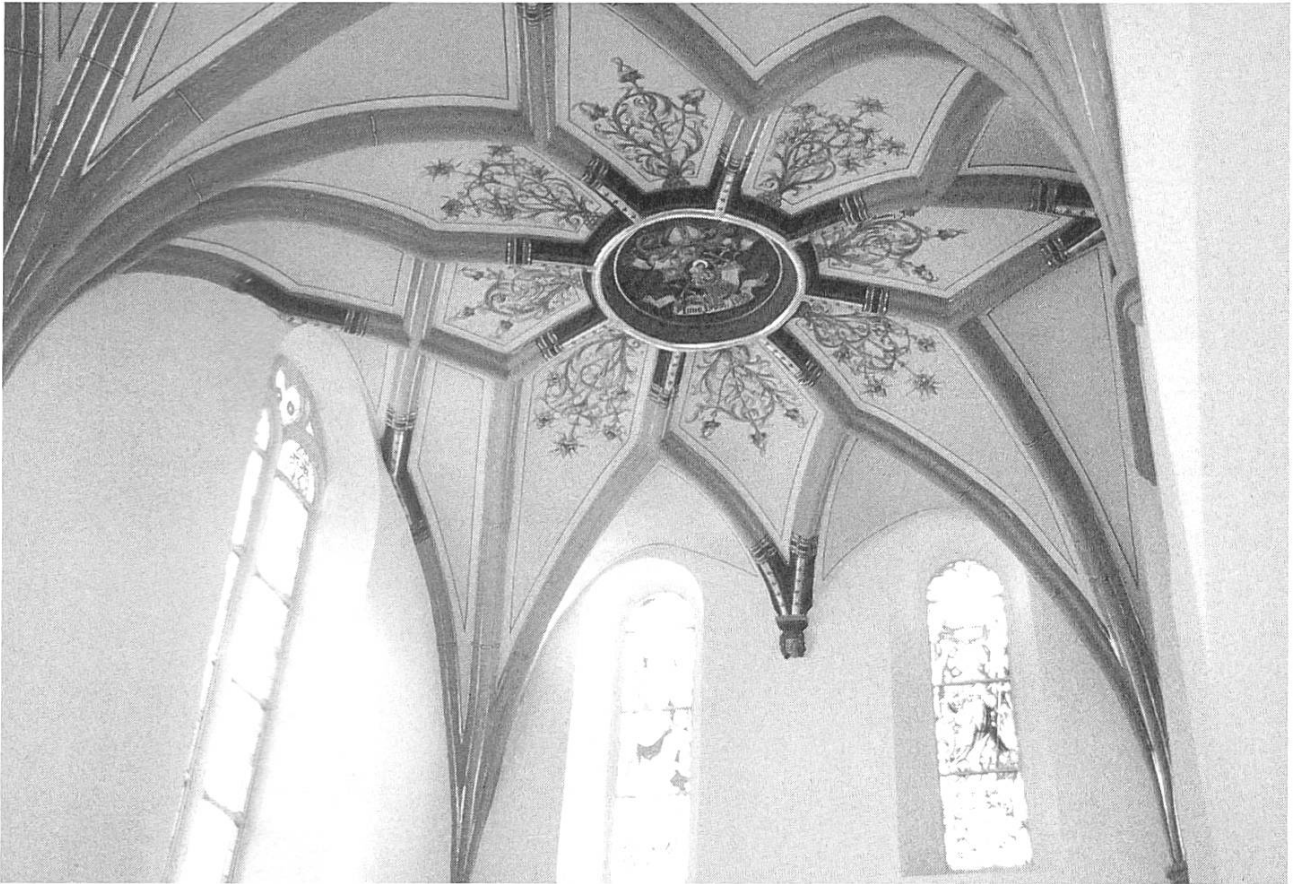
Gewölbe und die wieder eingesetzten Farbfenster der nördlichen Seitenkapelle, die dem heiligen Josef geweiht ist. (Foto: P. Notker Strässle)
