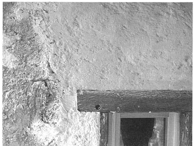
Abbildung 6: Gleiche Stelle wie Abb. 5, nach der Verputzergänzung.
