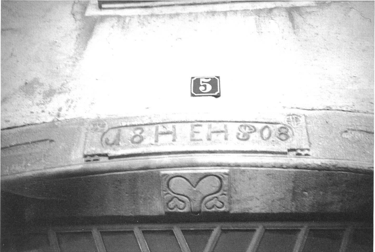
Abb. 6: Haustür an der nördlichen Fassade, verzierter und mit 1808 datierter Türsturz. (Foto M. Thommen, Sissach)
