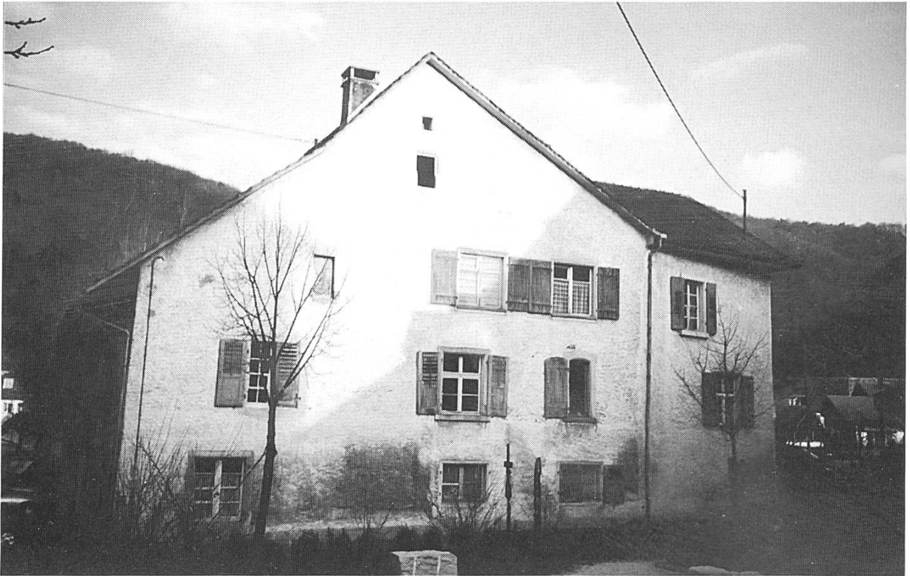
Abb. 13: Ansicht von Westen im März 1998. In den beiden obersten Geschossen je ein Fensterchen mit gotischen Gewänden. (Foto M. Thommen, Sissach)
