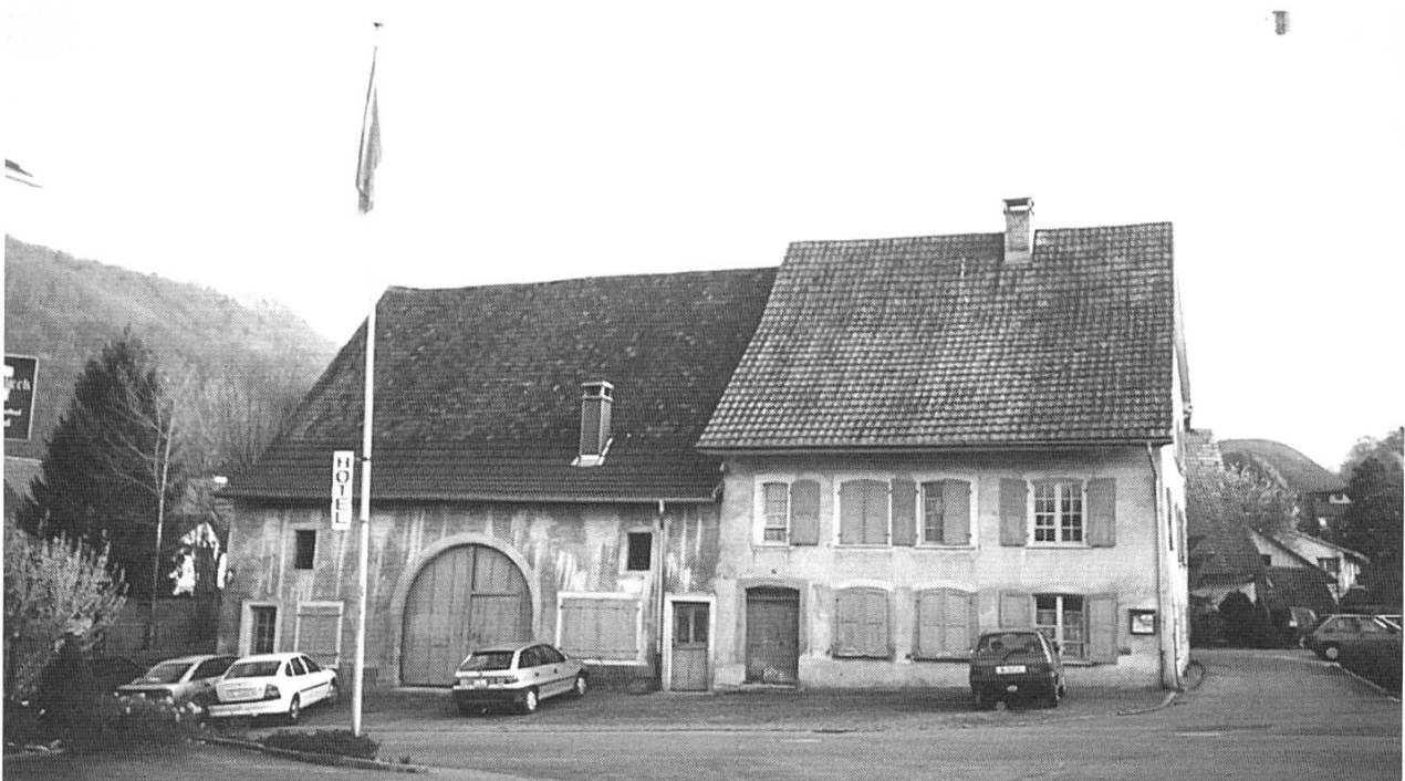
Abb. 1: Das Bohny-Haus von Norden. Rechts im Hintergrund der «Zunzger Büchel». Aufnahme vom März 1998, unmittelbar vor der Montage des Baugespanns für den damals vorgesehenen Um- und Ausbau zum Gemeindezentrum. (Foto M. Thommen, Sissach)
