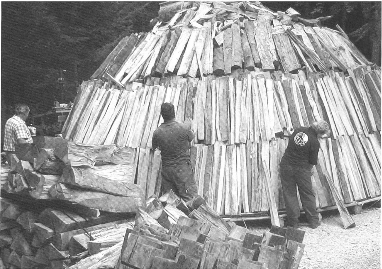
Aufbau eines Meilers in Hofstetten
