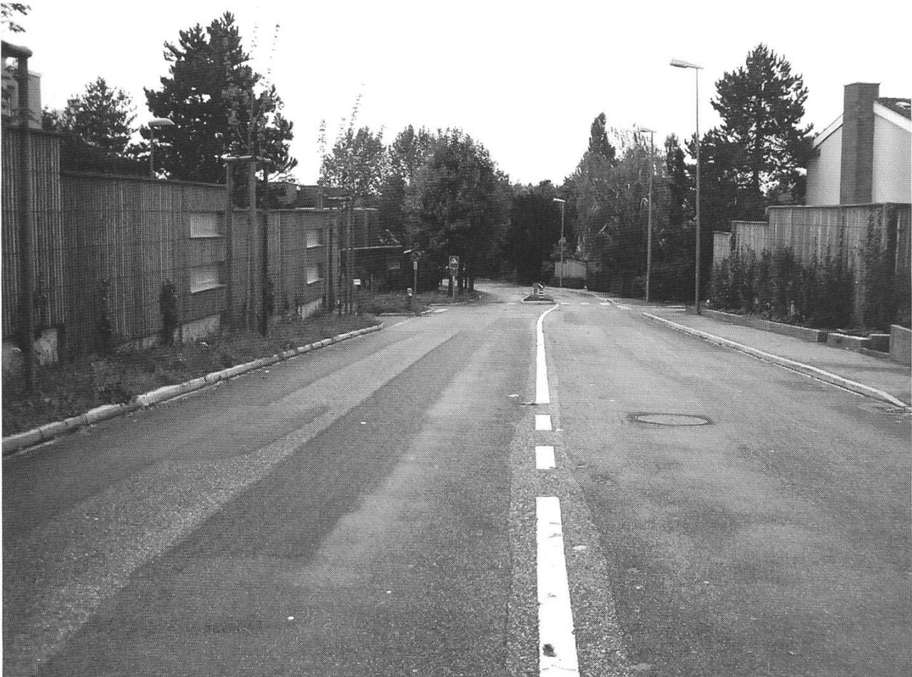
Abb. 14: Bottmingen: Beidseitige Schutzwände engen Sichtfeld ein.
