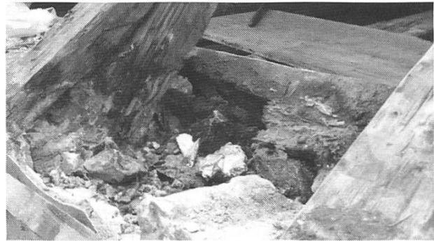
Abb. 1: Laufen, St. Katharinenkirche. Hausschwammbefall auf der Nordseite des Dachstuhls.
