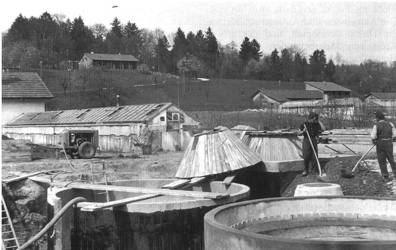
Die haus eigene Kläranlage beim Erlenhof, hier noch im Bau (1953), entlastete den Dorfbach von grossen Mengen Schmutzwassers. (Bild: Archäologie und Museen Baselland, Liestal)
