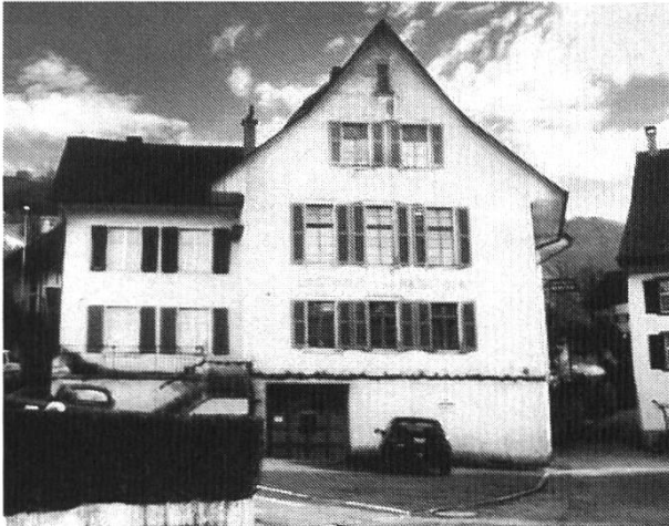
Abb. 1: Gasthaus Rebstock vor der Renovation.
