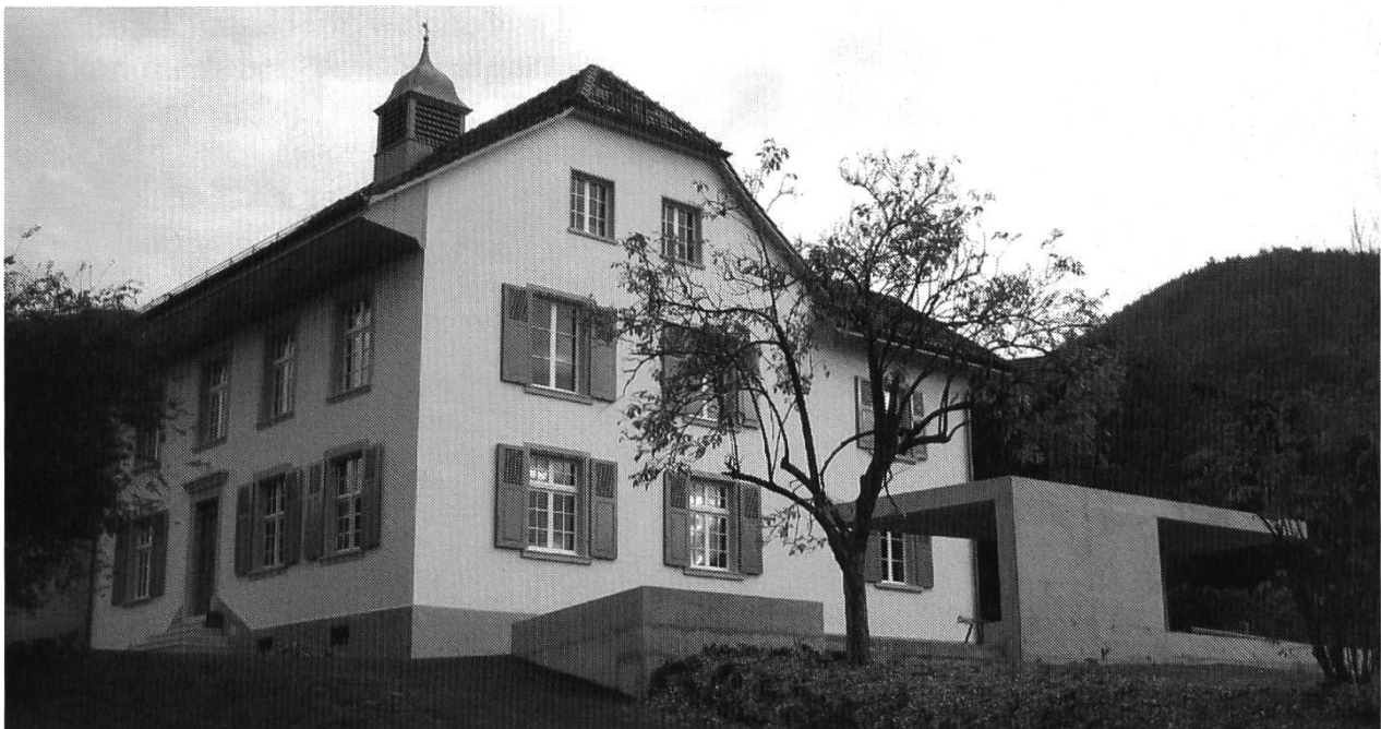
Abb. 23: Nach dem Umbau mit neuer Pausenhalle.
