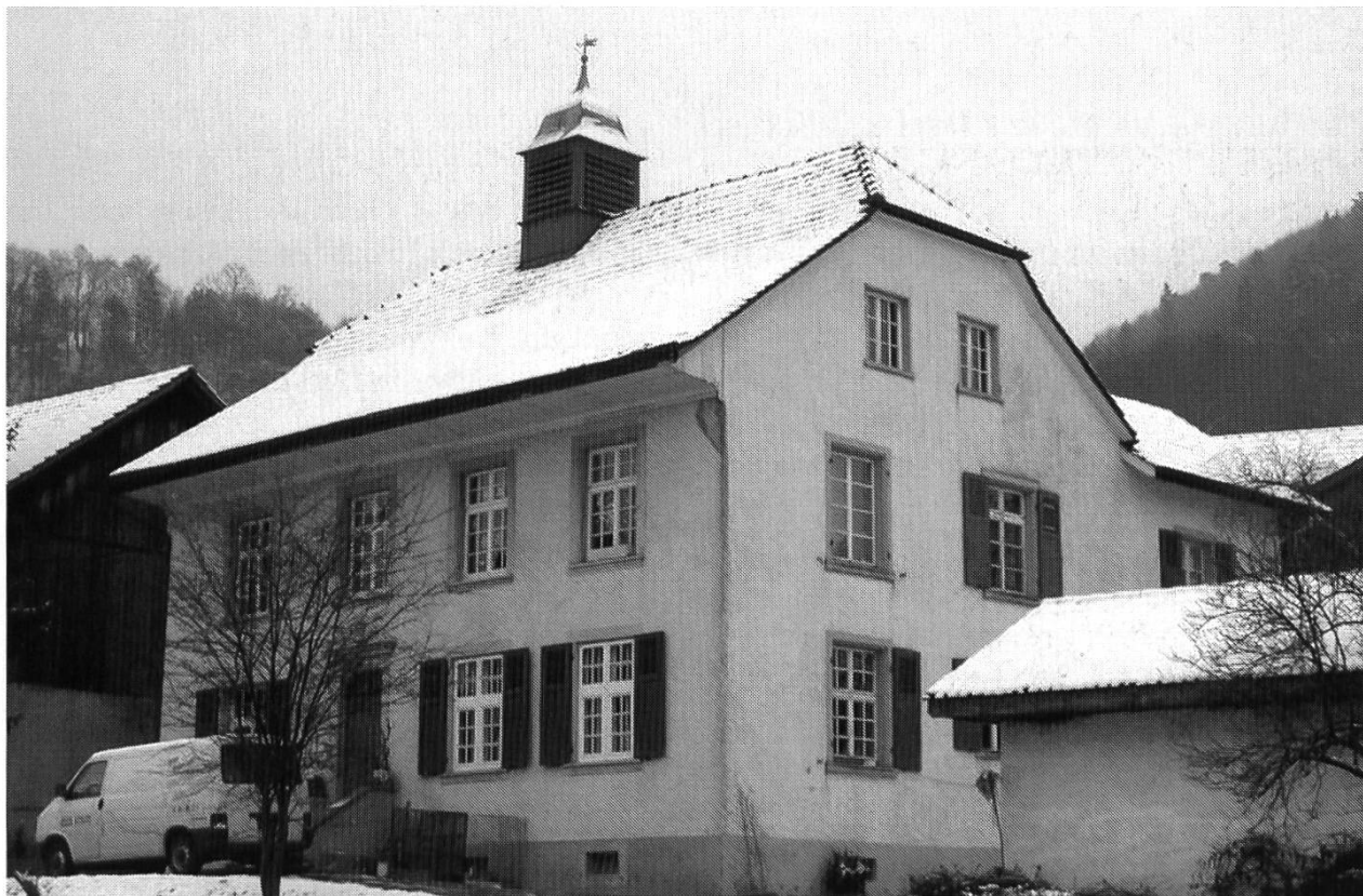
Abb. 14: Vor dem Umbau.
