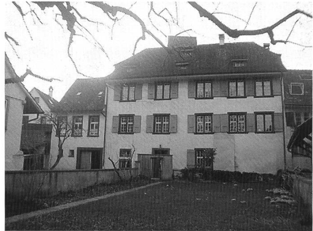
Das Pfarrhaus, Gartenfassade.
