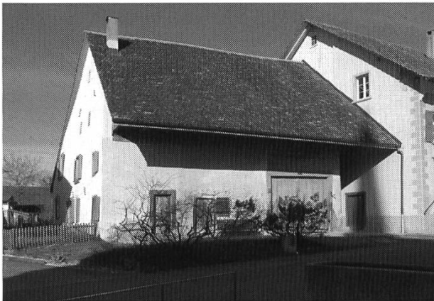
Strassenfassade nach der Sanierung.
