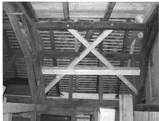
Neue Aussteifung mit Pfettenriegel und Windstreben.
